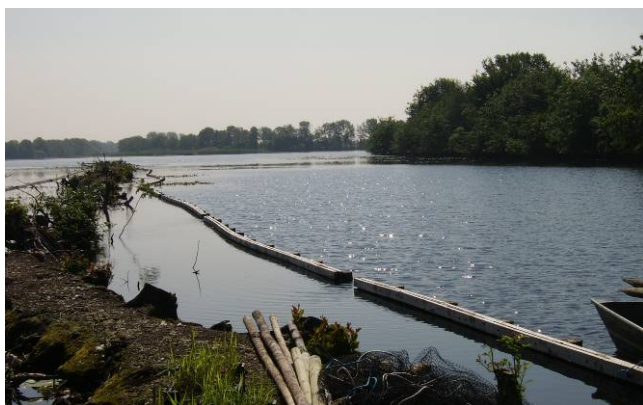
Figuur 10.30 Net aangelegde vooroever op Terra Nova. Duidelijk is te zien dat binnen de vooroever minder golfwerking is dan daarbuiten.
