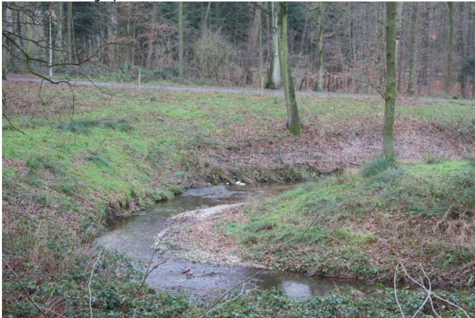
Foto 8: In trajecten van de Rode Beek in Zuid-Limburg is beekherstel uitgevoerd waarbij een meanderend lengteprofiel is aangelegd (foto Camiel Aggenbach).
