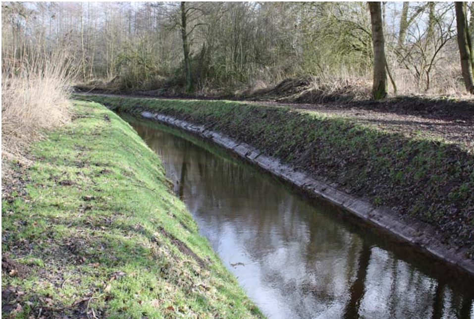
Foto 1: Een genormaliseerde en verdiepte waterloop in Twente. Door normalisatie is zeer weinig variatie in morfologie aanwezig wat nadelig is voor beekfauna en flora. Door de diepe drainagebasis heeft de waterloop gezorgd voor sterke verlaging van de grondwaterstand en verzuring in aangrenzend natuurgebied (foto Camiel Aggenbach).
